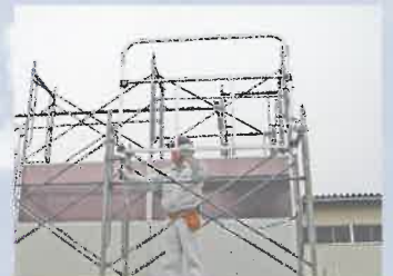
4. 先行手すり枠の下部固定金具にクサビを打ち込んで固定します。もう一方の下部固定金具を同様にクサビを打ち込んでセット完了。
