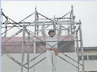
1. 先行手すりの枠の上部位置決め金具を枠組の横架材に乗せます。
