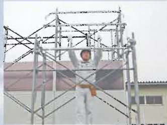
2. 先行手すり枠の下部固定金具が枠組の脚柱にセットできる位置まで半転させます。
