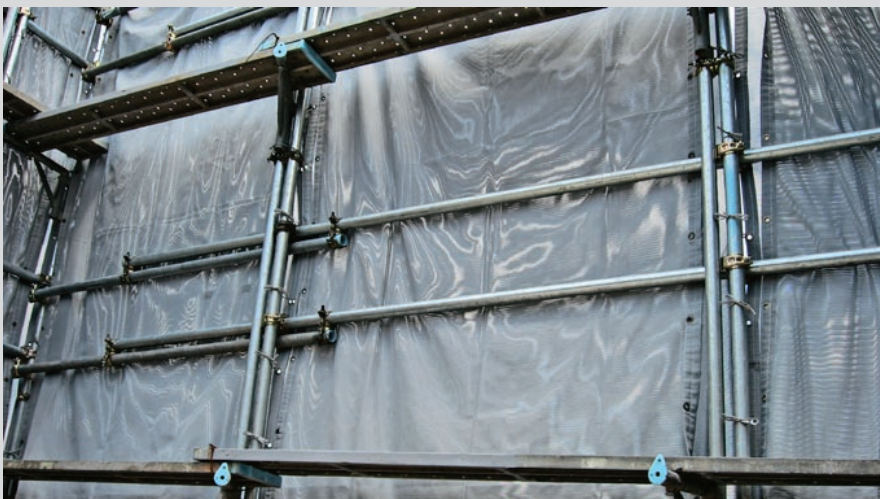
単管足場使用例
