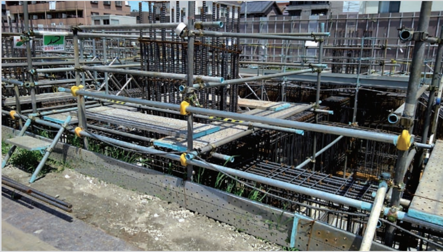
単管パイプ使用例
